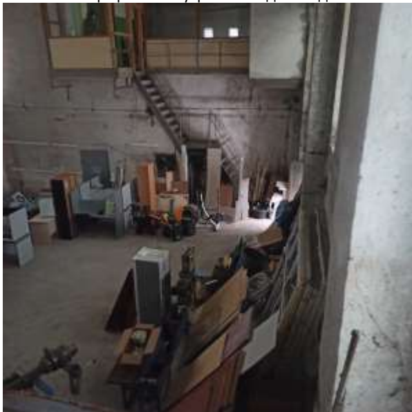
Фотография 25 Внутренняя отделка здания
