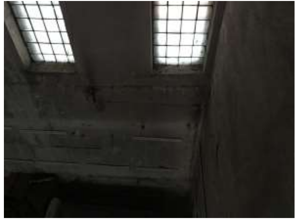
Фотография 22 Внутренняя отделка здания
