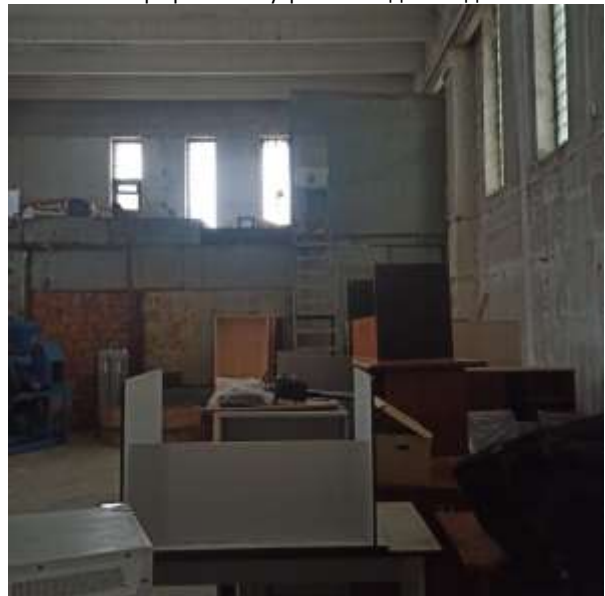
Фотография 26 Внутренняя отделка здания
