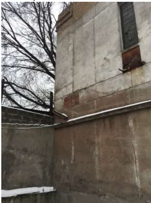
Фотография 2 Общий вид здания
