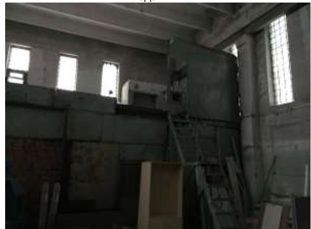
Фотография 12 Внутренняя отделка здания
