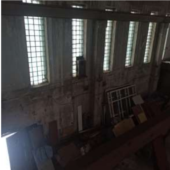
Фотография 23 Внутренняя отделка здания
