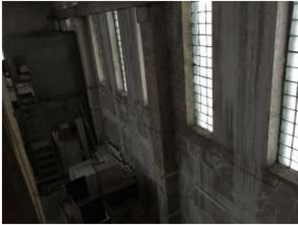
Фотография 21 Внутренняя отделка здания
