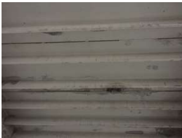
Фотография 14 Состояние перекрытий
