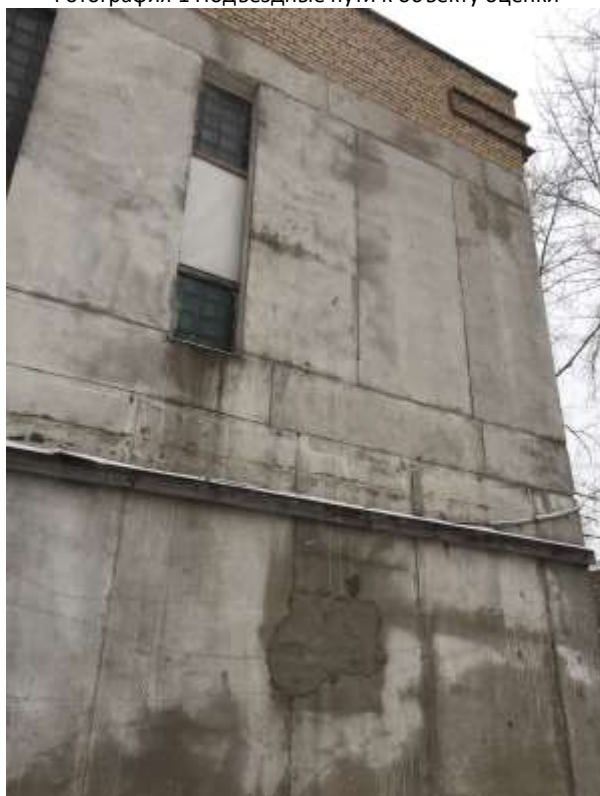
Фотография 3 Общий вид здания
