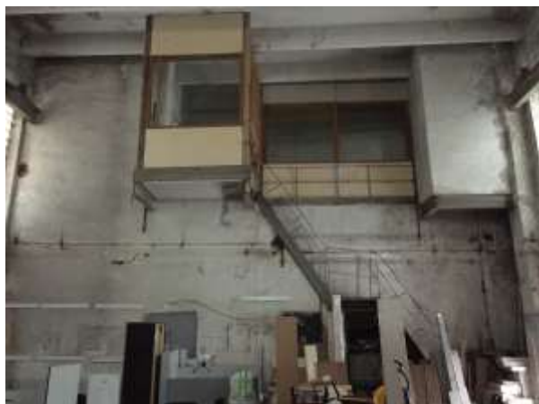
Фотография 13 Внутренняя отделка здания
