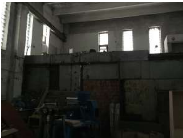
Фотография 11 Внутренняя отделка здания
