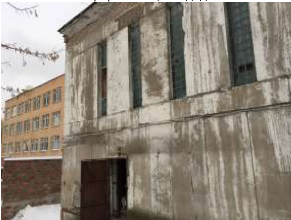
Фотография 9 Общий вид здания
