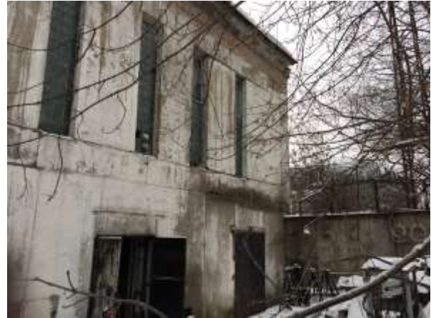
Фотография 8 Общий вид здания
