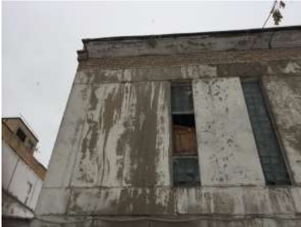
Фотография 7 Общий вид здания
